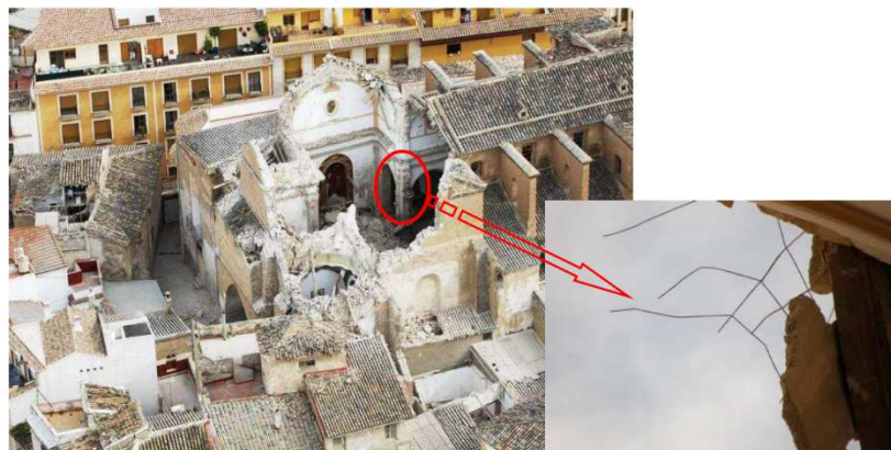
FIGURA 56. Colapso de la cúpula y del crucero de la iglesia de Santiago y detalle de mallas de refuerzo.
